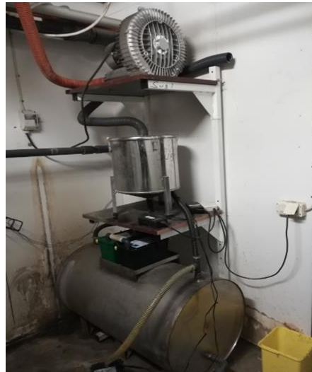
Exempel på äldre vått sugsystem med sedimenterande amalgamavskiljning.
