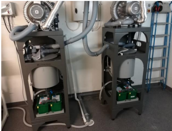
Exempel på nytt vått sugsystem med sedimenterande amalgamavskiljning
