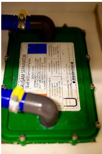
Sedimenterande amalgamavskiljare
